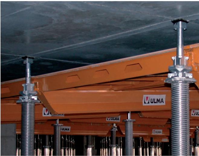
► Desencofrado con cabezal de caída
