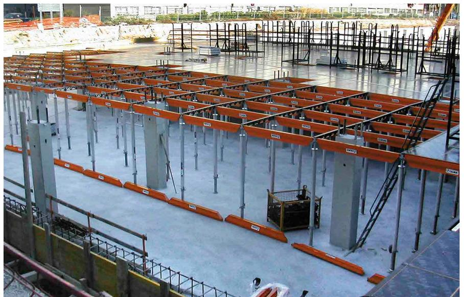
► Posibilita diferentes equipos de trabajo para montaje de retícula y paneles
