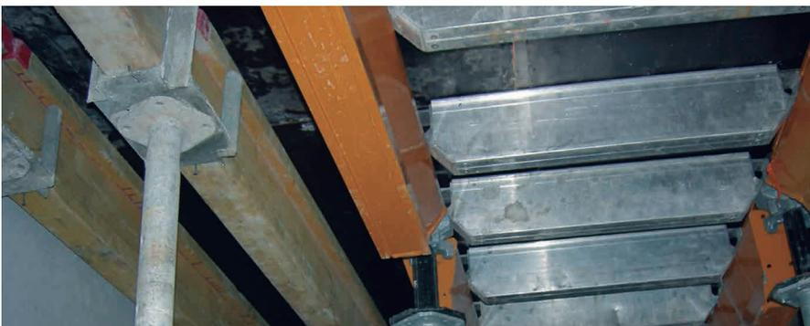
► Vigas VM sobre puntal que proporcionan apoyo al tablero de remate
