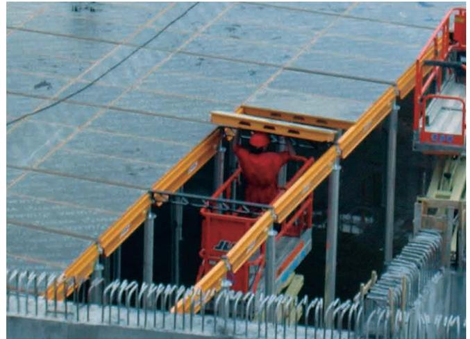
► Montaje de paneles por debajo con total seguridad
