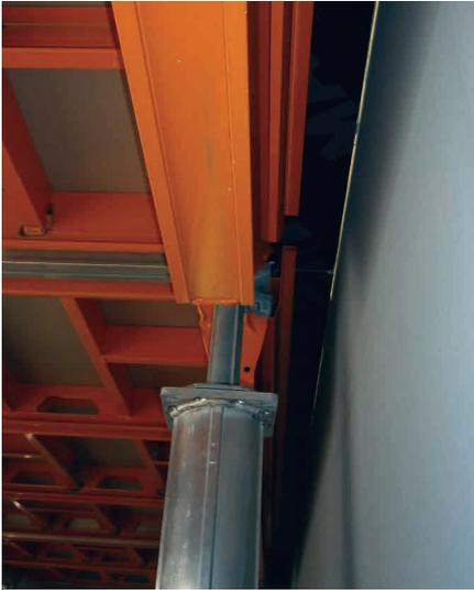
► Remate contra muro con viga esquinual, que proporciona apoyo al tablero de remate
