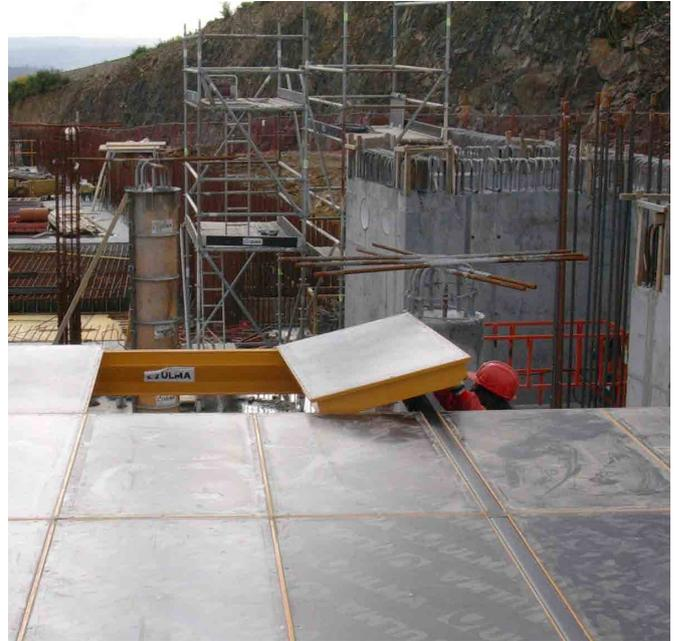
► Facilidad de montaje deslizando los paneles
