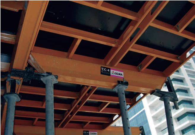
► Salida a 90° de viga sobre viga
