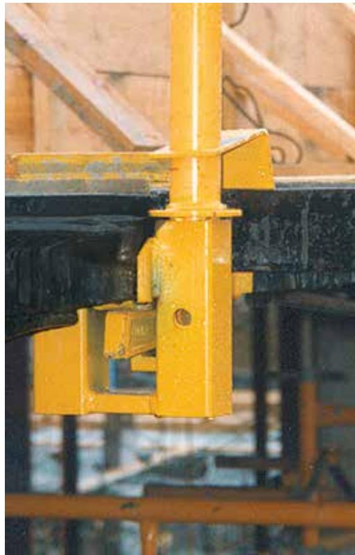
Provisto el encofrado con todas las protecciones laterales, nos ocuparemos de la protección de borde de los forjados en la fase de desencofrado. Emplearemos, con ese fin, el Taco de Forjado.
