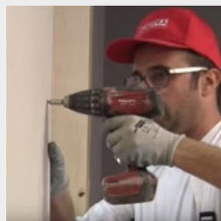
Atornillar las placas en los travesaños verticales sobresalientes del armazón a la altura que se desee.
