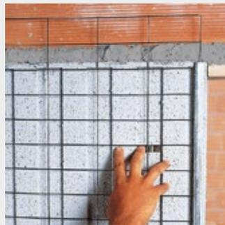
Colocar la red metálica y fijar con los clips suministrados.
