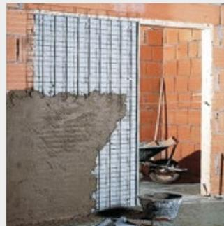
Enfoscar. Con el modelo Plus una única capa de enfoscado será suficiente ya que se suministra preenfoscada.
