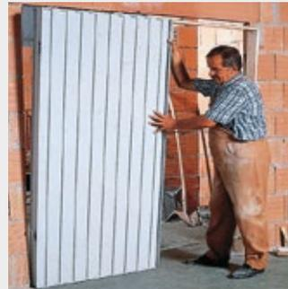
Colocar el armazón, nivelar y fijar a la pared con las garras de sujeción (incluidas) y puntos de cemento o yeso.
