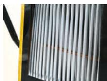
La separación entre los tubitos del intercambiador, evitan que estos se atasquen.
